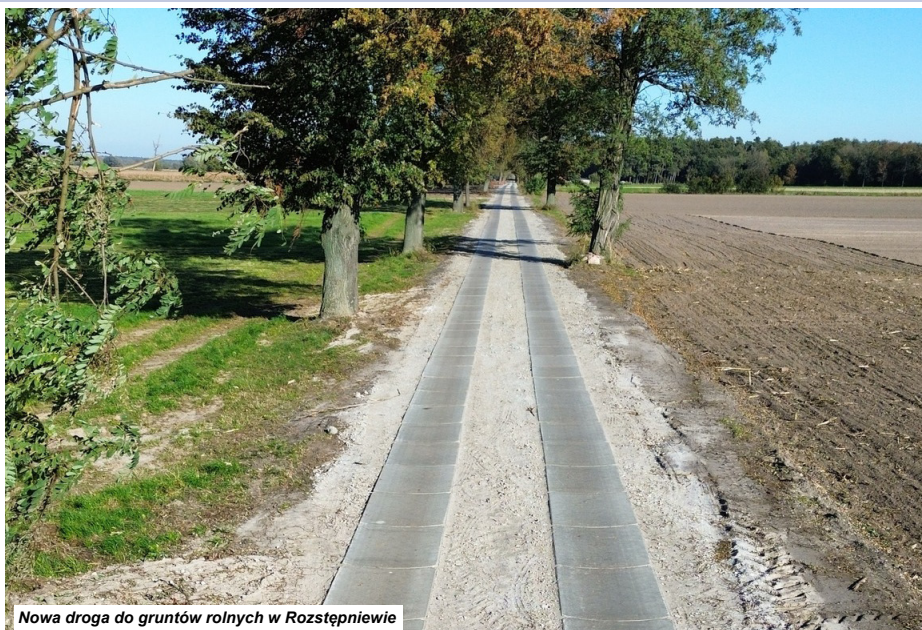
Nowa droga do gruntów rolnych w Rozstępniewie
