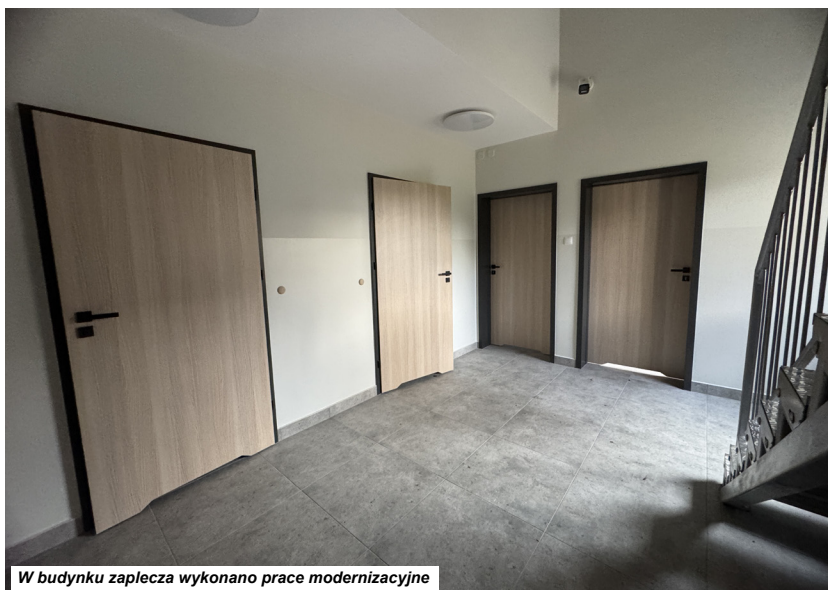
W budynku zaplecza wykonano prace modernizacyjne
