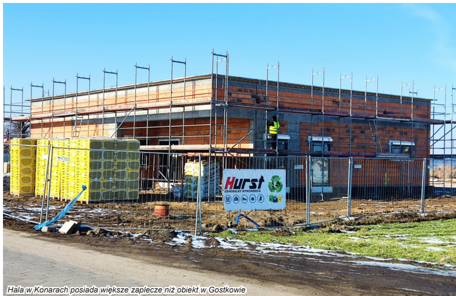
Hala w Konarach posiada większe zaplecze niż obiekt w Gostkowie
