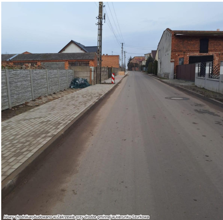
Nowy chodnik wybudowano w Zakrzewie przy drodze gminnej w kierunku Szurkowa
