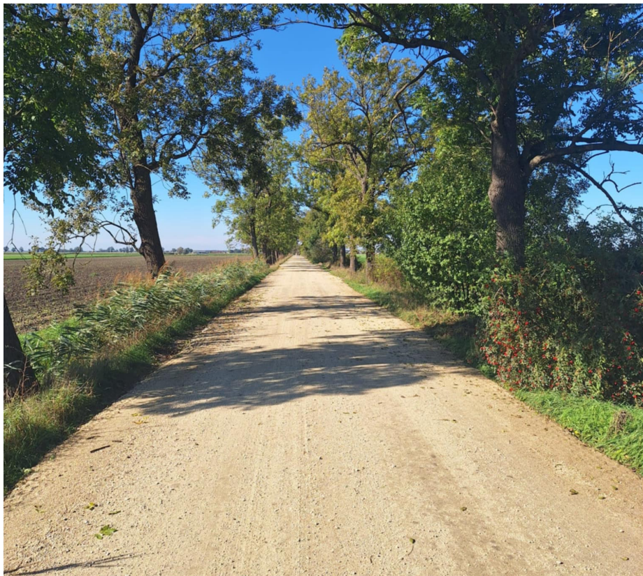
Utwardzona droga z Dłoni do Oczkowic
