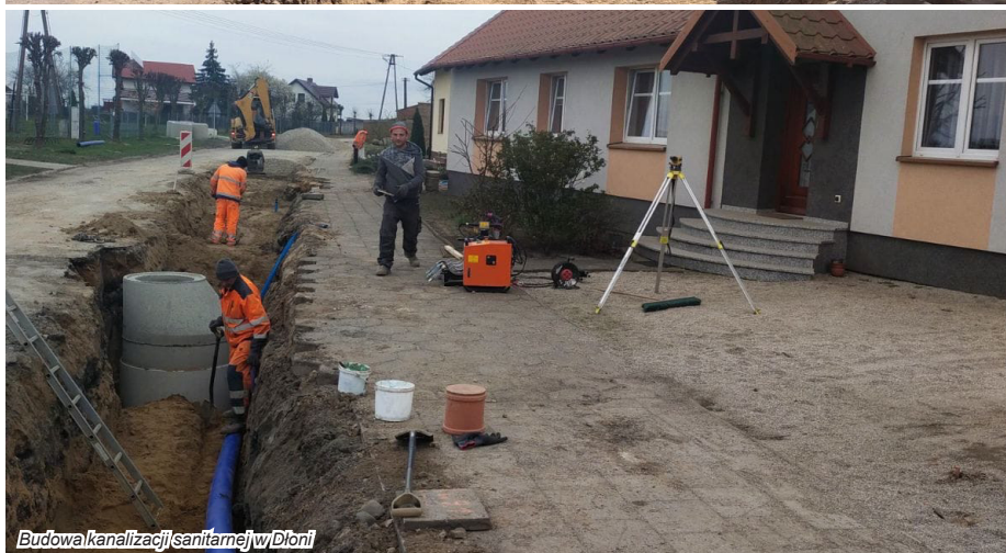
Budowa kanalizacji sanitarnej w Dłoni
