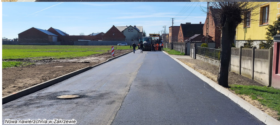
Nowa nawierzchnia w Zakrzewie
