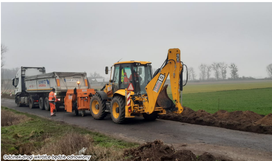
Odcinek drogi wkrótce będzie odnowiony
