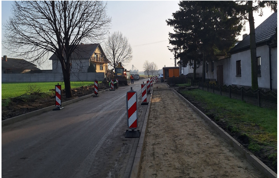
Budowa chodnika na ulicy Kościuszki w Dąbrowie
