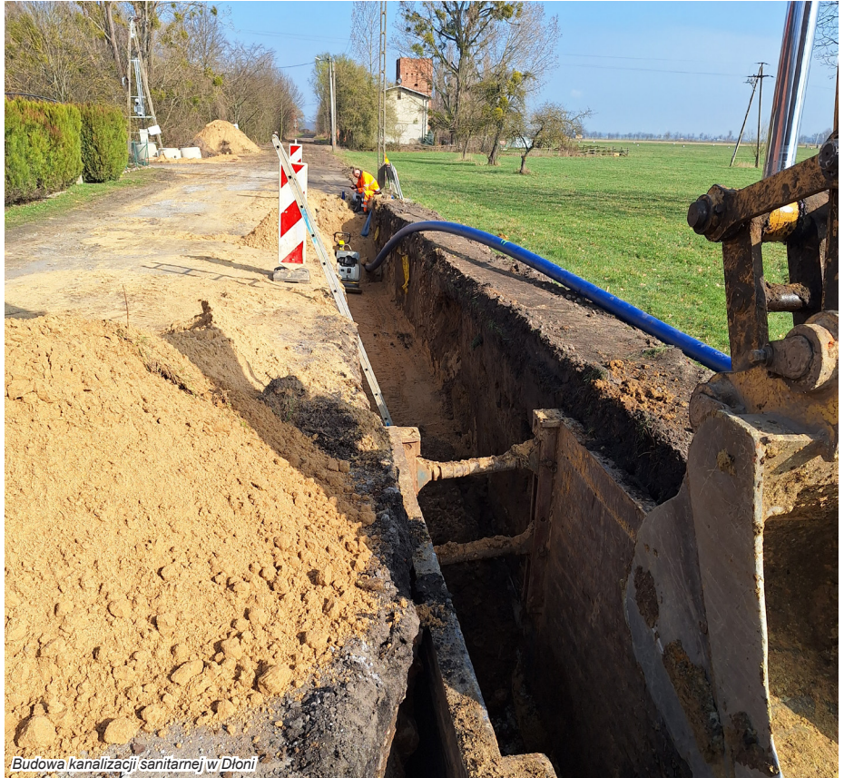
Budowa kanalizacji sanitarnej w Dłoni
