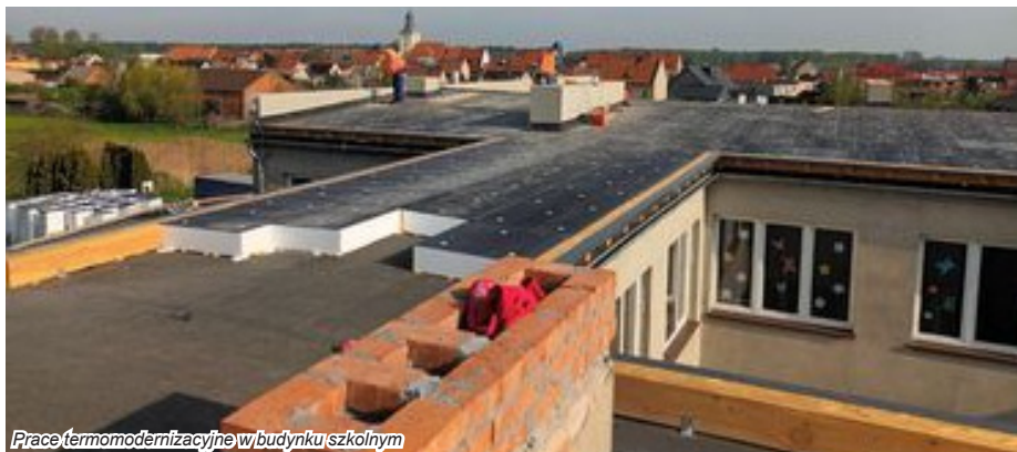
Prace termomodernizacyjne w budynku szkolnym
