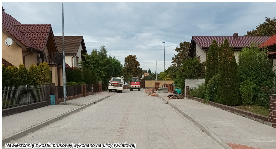
Nawierzchnię z kostki brukowej wykonano na ulicy Kwiatowej
