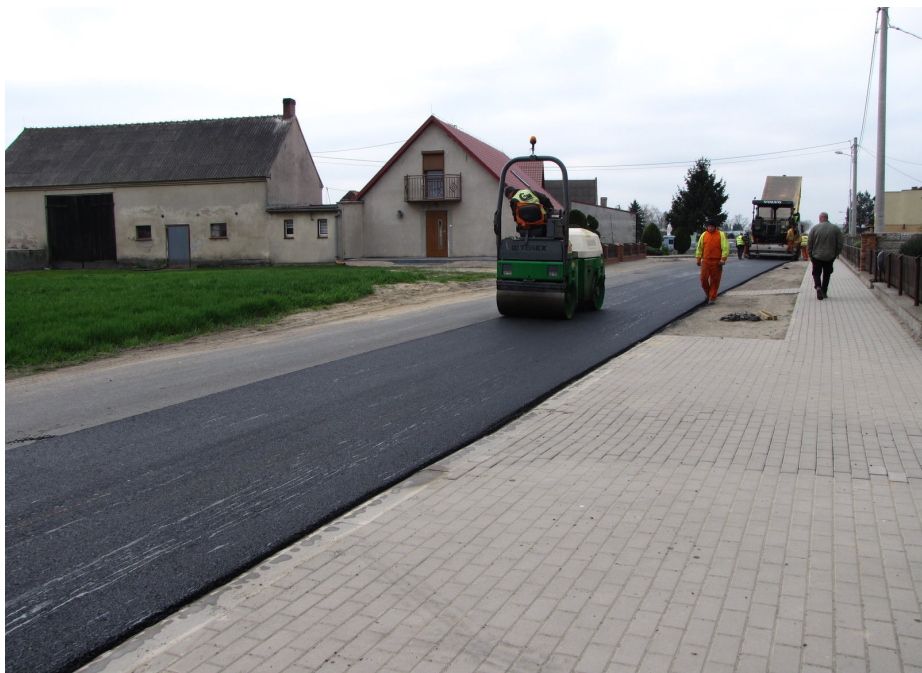
Układanie nowej nawierzchni na drodze w Kołaczkowicach po wybudowaniu kanalizacji sanitarnej
